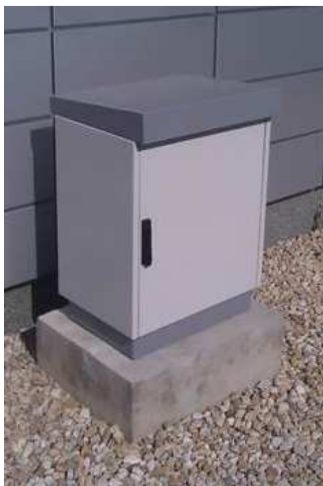
OBR. 49 – PŘÍKLAD VENKOVNÍ KLIMATIZOVANÉ SKŘÍNĚ (ANTIVANDAL PROVEDENÍ)
